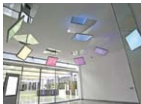
Потолочное освещение в залах аэропортов, на заправочных станциях и сервисных центрах бытового обслуживания.
